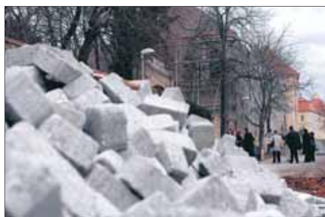
Viele Bauarbeiten stehen noch aus: In der Museumsstraße wird gerade das Straßenpflaster erneuert.
